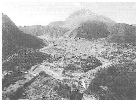
写真-2 千本木1号砂防ダム
