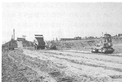
写真-3 砂防ダムの無人化施工状況
