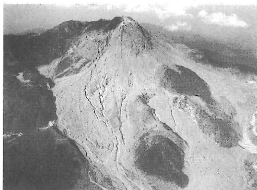
写真-14 赤松谷川ガリーの発達状況
