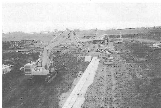
写真-4 ブロック型枠施工状況
