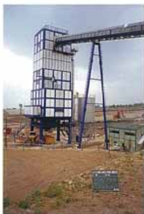
現地バッチャープラント 現地発生材にセメントを混合してCSG材を製造します。
