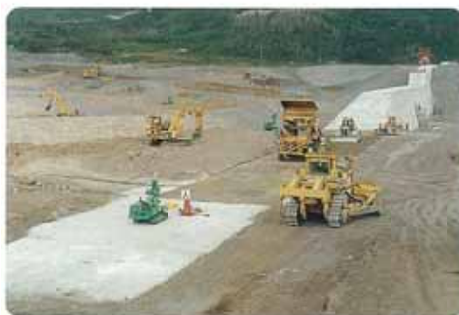
無人施工によるダム施工状況
