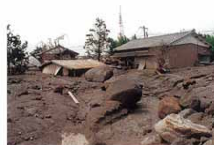
○土石流により埋没した家屋（H5.4.29）
