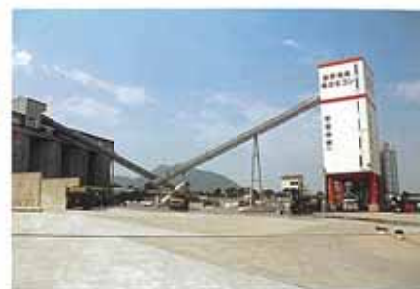
生コン工場 RCC用コンクリート（超硬練コンクリート）を製造します。
