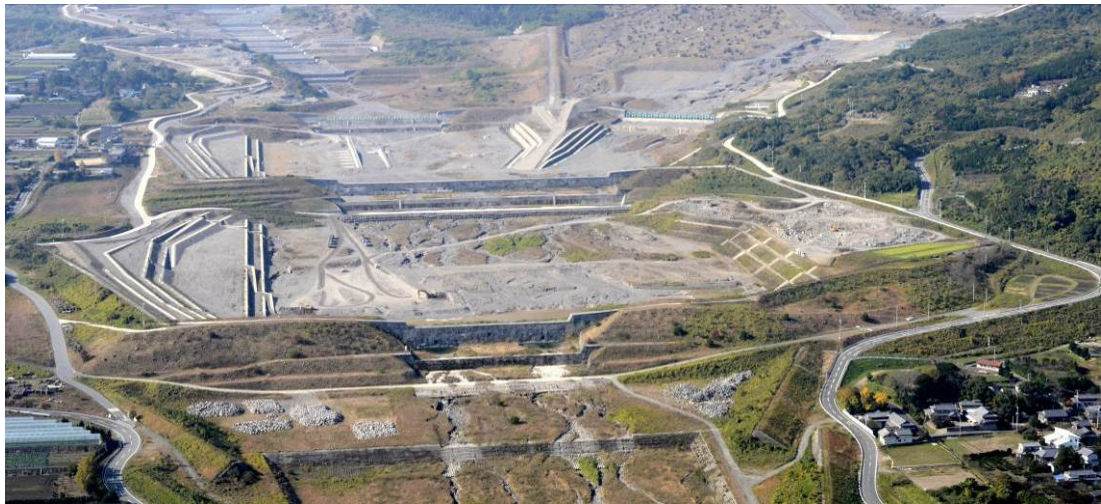
写真2. 現在の水無川1号砂防堰堤と水無川2号砂防堰堤 (平成23年12月撮影)
