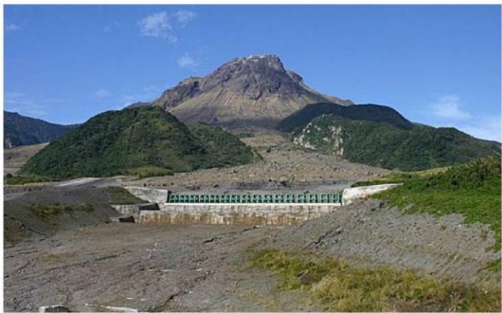
写真 1 水無川 3 号砂防堰堤
