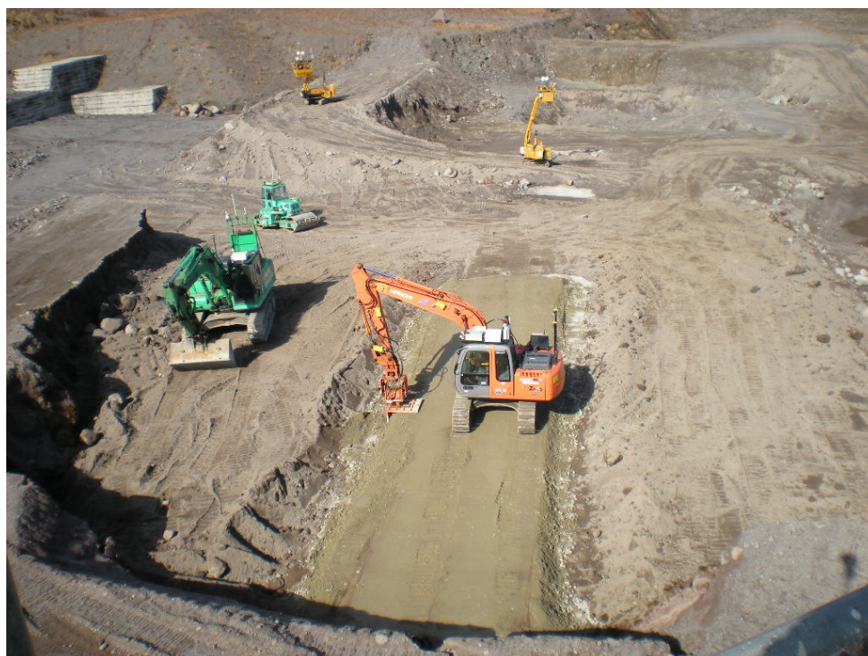
①RCC打設後、法肩を締め固める
