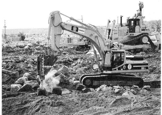
写真-4 無人ブレーカによる岩破碎状況
