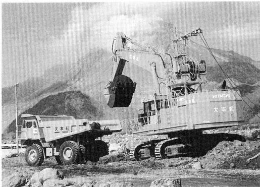
写真-1 無人バックホウによる積込作業状況
