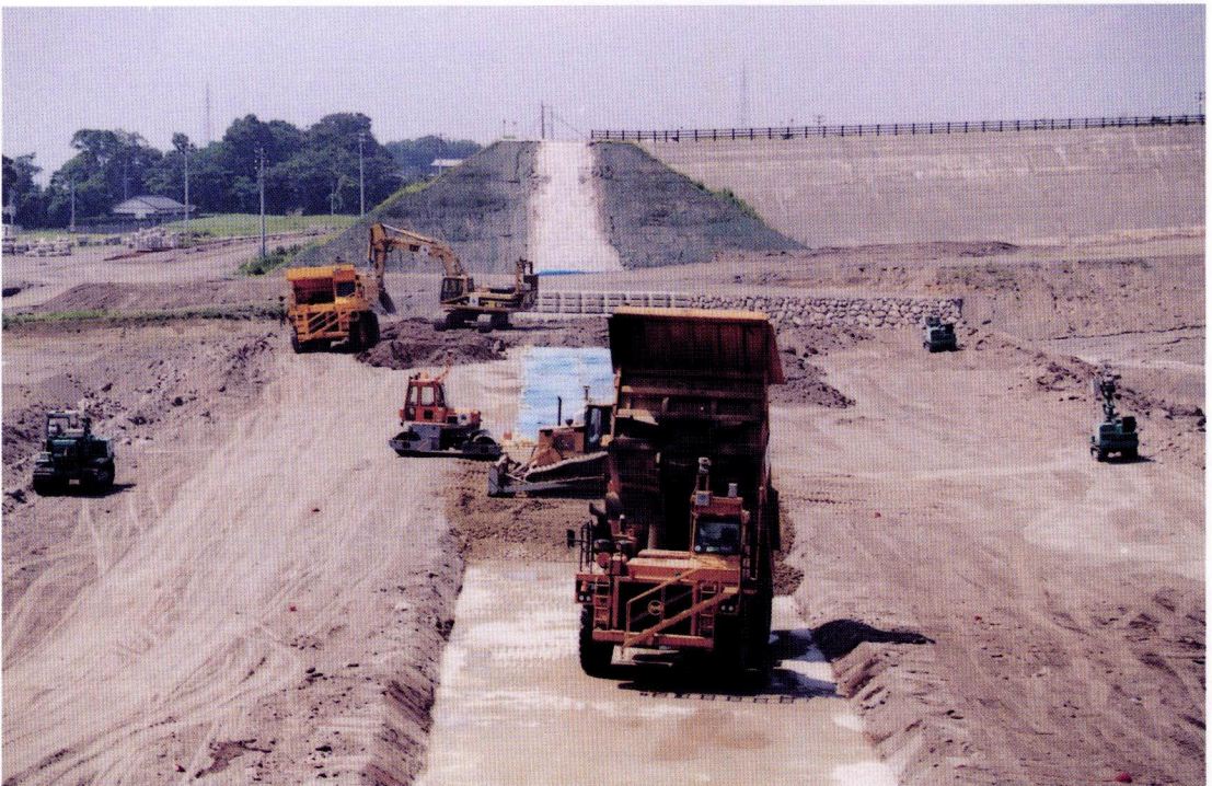
水無川 1 号砂防ダムの施工状況
