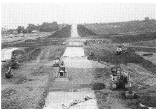
写真-3・4 水無川1号砂防ダム無人化施工状況
