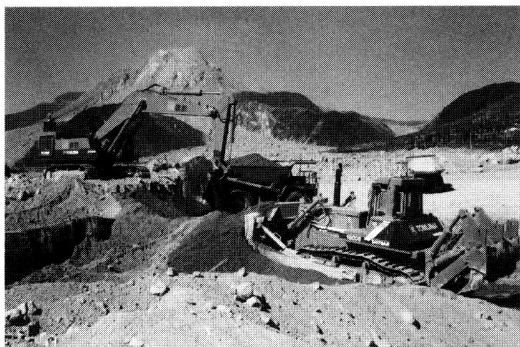
写真-2 無人化除石工事実施状況
