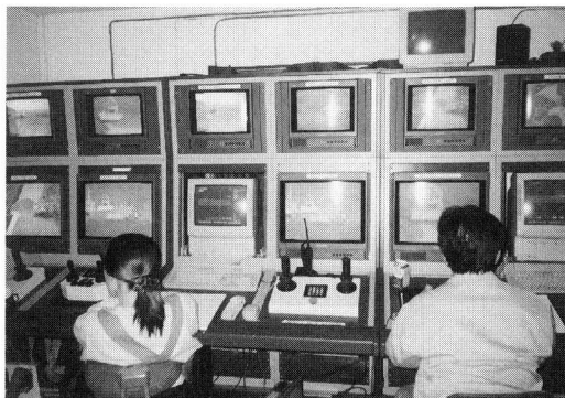
写真-5 操作室での遠隔操作状況
