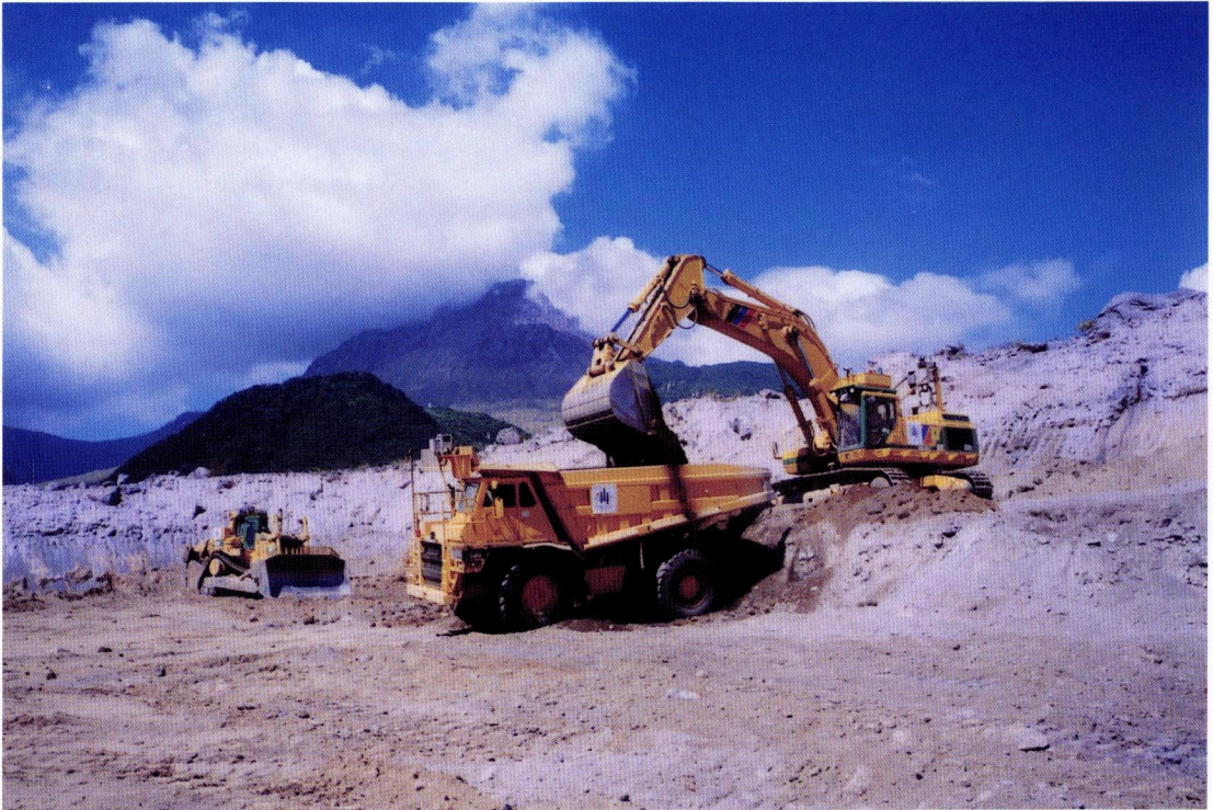
水無川 2 号ダム上流の除石工事
