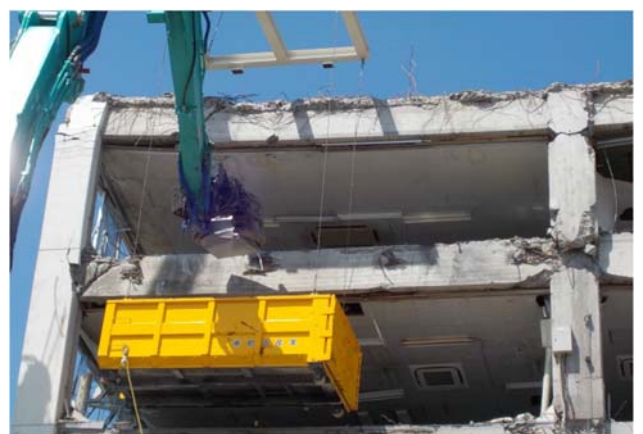
写真8 重要備品等回収(クラム付きアーム)
