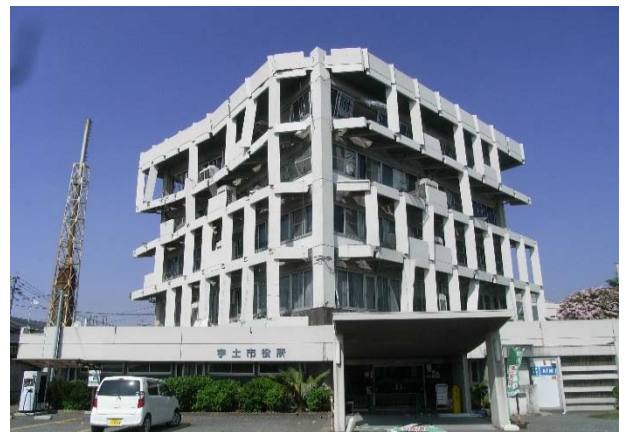
写真1 宇土市庁舎被災状況
