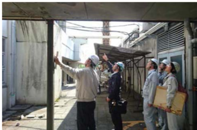
写真3 被災庁舎の確認状況
