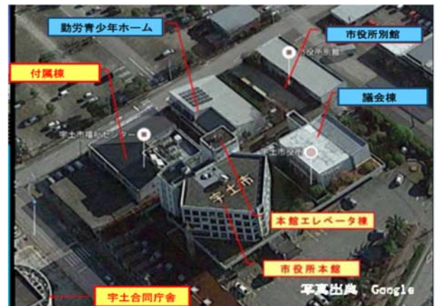
写真2 市庁舎の敷地周辺状況
