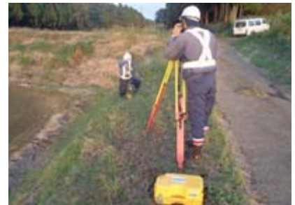
写真ー2 幅杭設置状況
