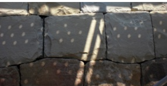
写真9 新材の目地うねり調整
