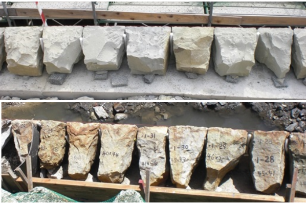
写真7 上段：新材仮配置、下段：再生材仮配置
