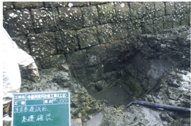
写真10 トレンチ掘削調査状況
