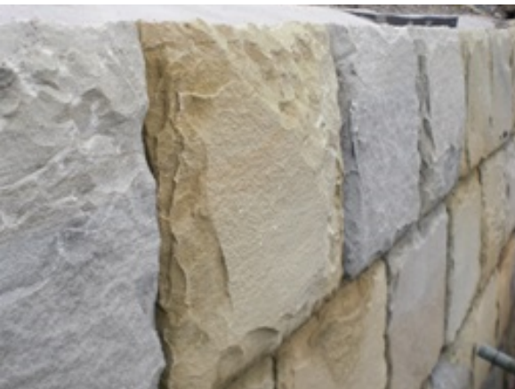
写真8 新材の表面加工
