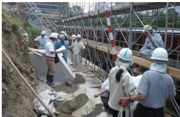
写真4 施工監理状況
