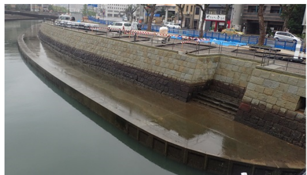
写真13 完成した石積護岸
