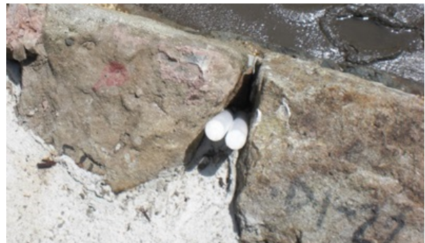
写真12 目地奥に設置されたバックアップ材
