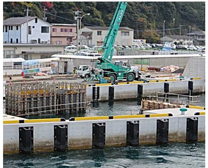
図-9 作業区域と旅行者通路の近接
