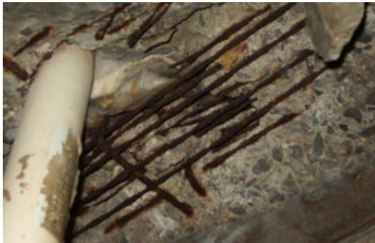
【老朽化した橋梁の状況】
