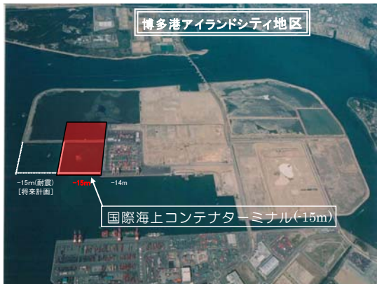
図 博多港国際海上コンテナターミナル(福岡市)
