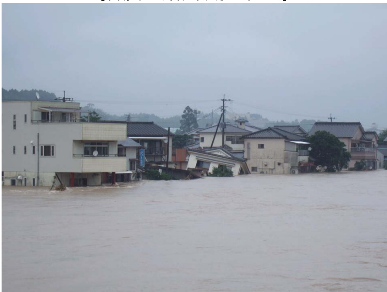
【集中豪雨による水害の状況(さつま町 2006.7)】
