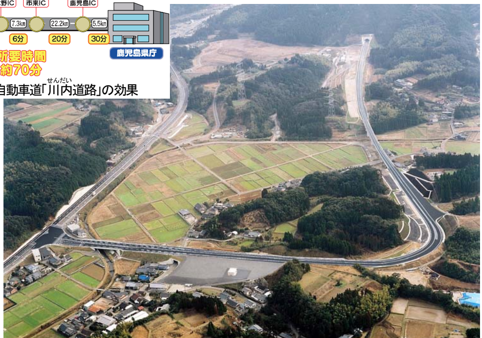
図 南九州西回り自動車道川内道路「薩摩川内都IC」(薩摩川内市)
