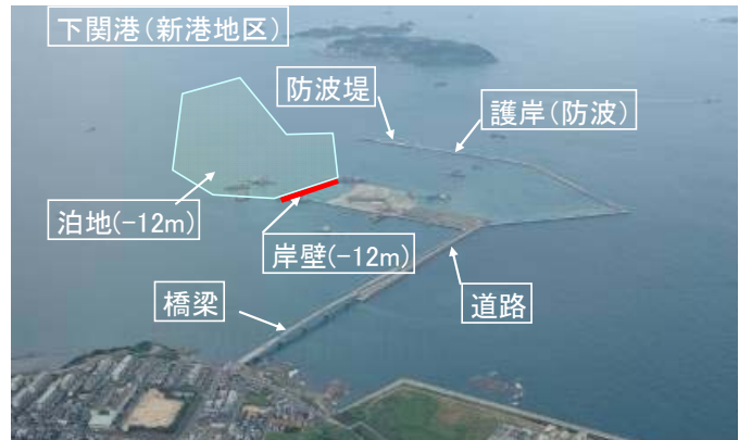
図 下関港多目的国際ターミナル整備事業(下関市)
