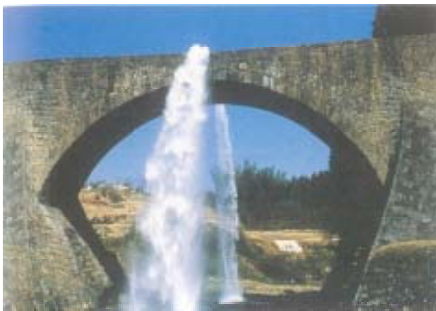
写真 1-4 通潤橋（熊本県 / 安政元年 1854 年完成）
