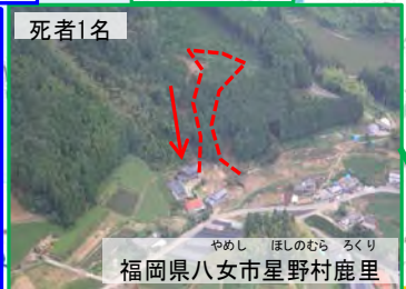
7/14 がけ崩れ発生
