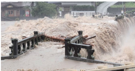
令和5年7月10日洪水（耶馬溪橋）
