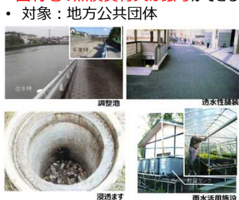
雨水貯留浸透施設の例
