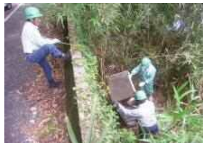
維持工事による不法投棄粗大ゴミの撤去
