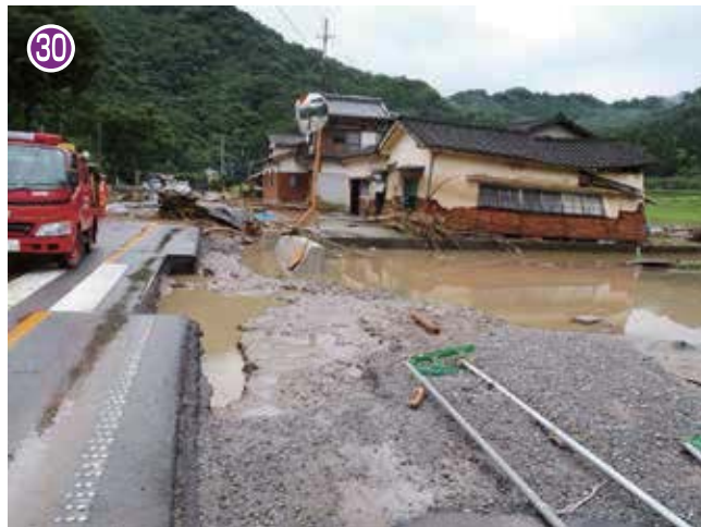
被災した家屋（7月14日出水）
