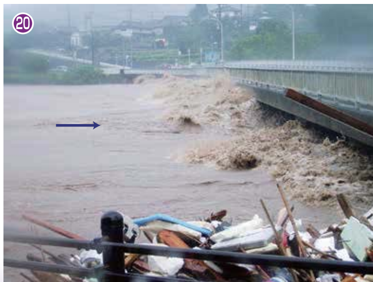
濁流が押し寄せる洞門橋（7月14日出水）
