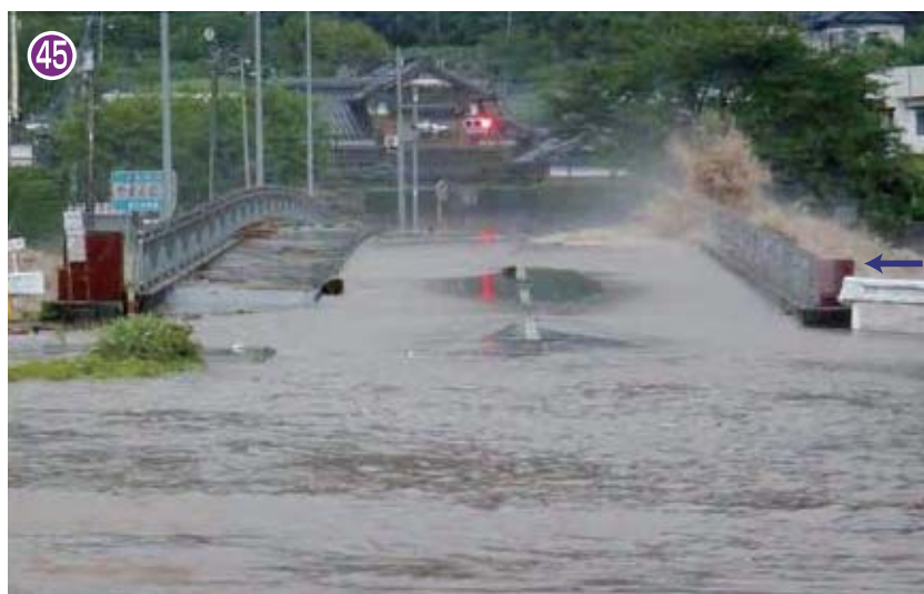
橋を越えている濁流（7月14日出水）
