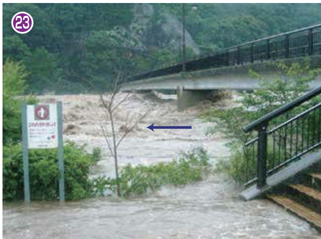
駐車場に押し寄せる濁流（7月14日出水）
