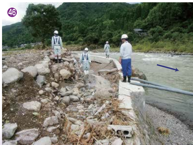
洗掘された護岸の復旧方法の検討（7月3日出水）
