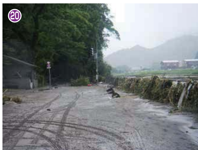
土砂が溜まった道路（7月3日出水）
