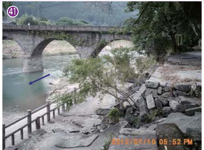
被災した馬溪橋付近の護岸（7月3日出水）
