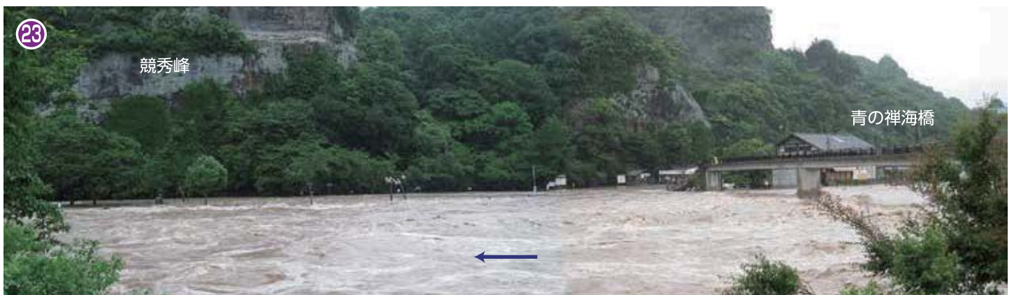
水没する駐車場（7月14日出水）
