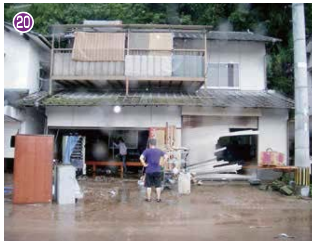
泥にまみれた家屋（7月3日出水）
