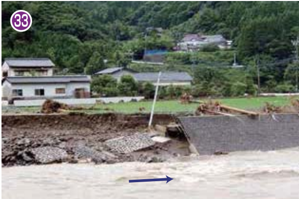
崩壊した護岸 (7月14日出水)
