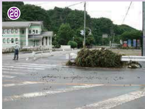
越流した水が流れた痕跡（藤野地区）（7月3日出水）
