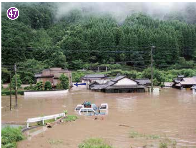
越水により水没している家屋（7月3日出水）
