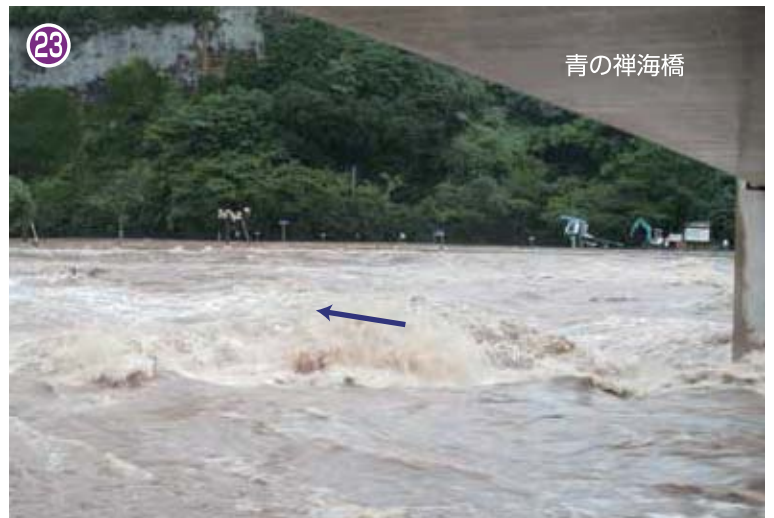
水没する駐車場（7月14日出水）
