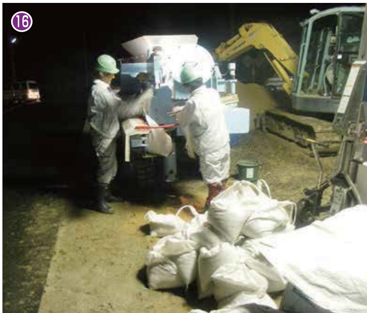
土のう製造器で大量に作られる土のう（7月3日出水）
