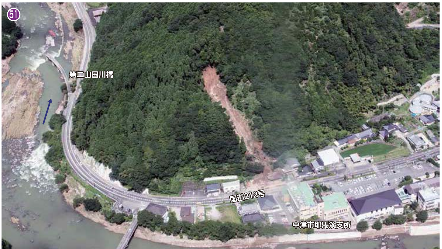
土砂崩れ（7月14日出水）
