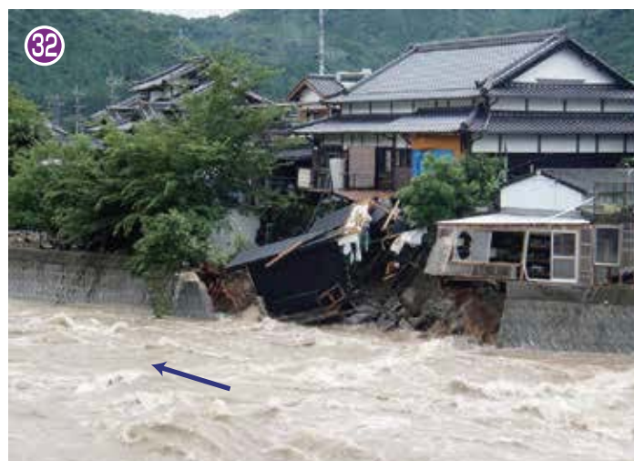
護岸と家屋の崩壊 (7月14日出水)
