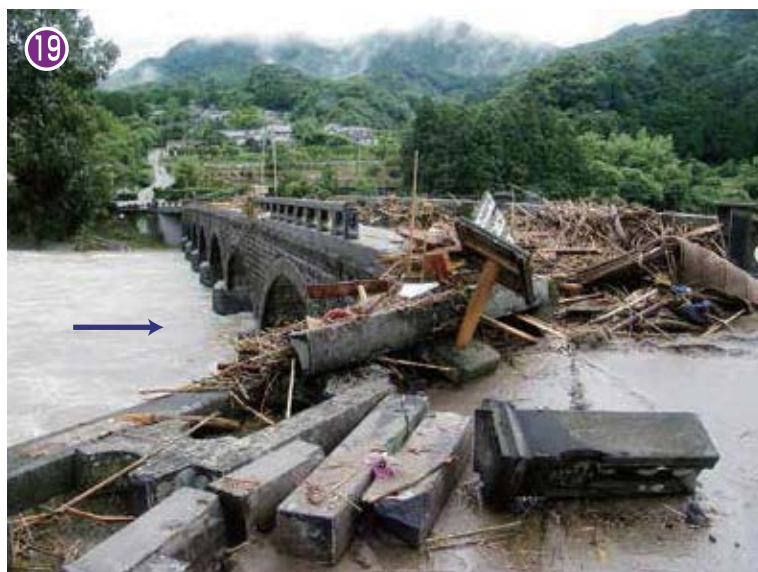
被災した耶馬溪橋（7月3日出水）
