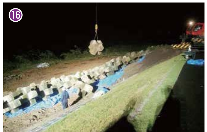
夜を徹して行われる復旧作業（7月3日出水）
