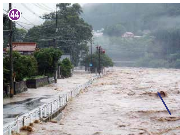
越水している様子（7月14日出水）
