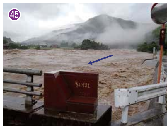
堤防ギリギリを流れる濁流（7月14日出水）
