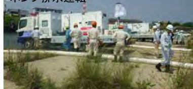
ポンプ排水運転
