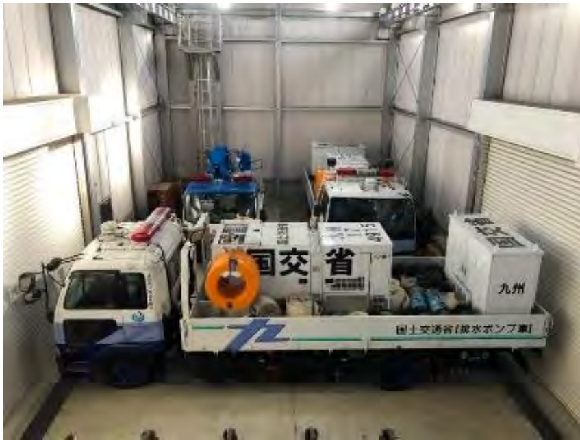
平成大堰予備ゲート庫
