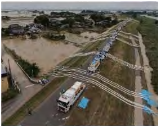
写真1. 排水ポンプ車の排水状況事例
