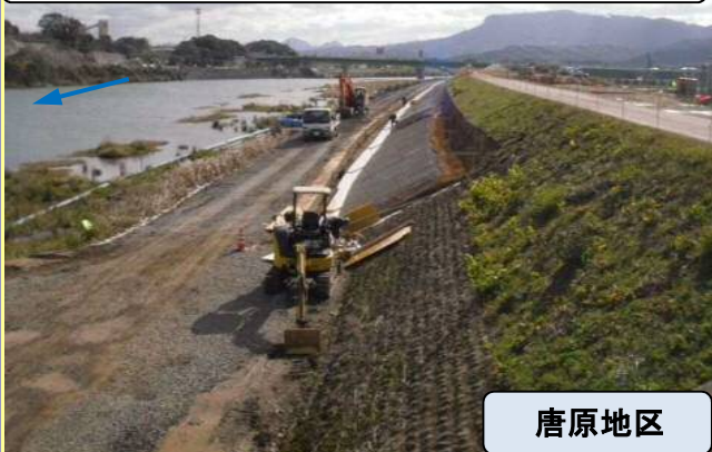
②唐原地区護岸外工事：護岸設置の作業状況
