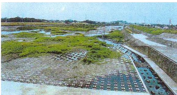
写真 2.2.1 平成大堰下流の渇水状況 (平成 13 年)
