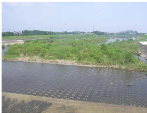
写真 2.1.1 土砂堆積及び樹木繁茂状況
