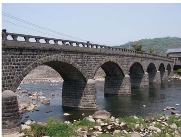
写真 2.3.7 耶馬溪橋（オランダ橋）
