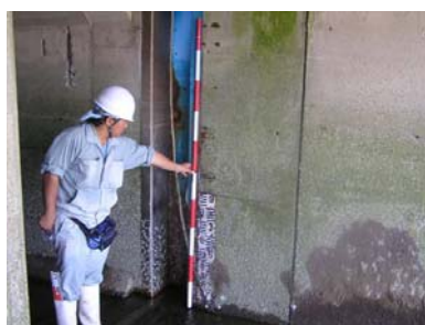
写真 2.1.3 水門（樋門樋管）等の点検状況
