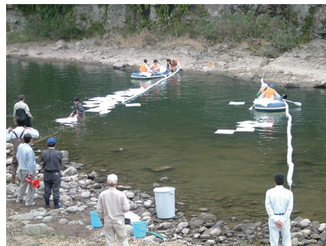
オイルフェンス、吸着マットの設置状況（水質事故訓練にて）
