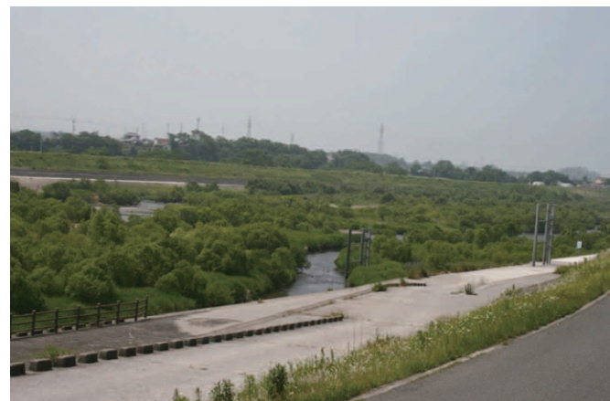
河道内の樹木繁茂状況
