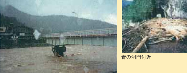
平成5年9月洪水 青地区(橋の流出)
