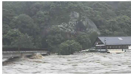
中津市本耶馬溪町宮木地区の越水による浸水被害状況 (平成24年7月洪水時)
