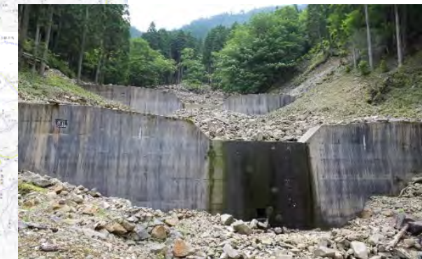
土砂を捕捉した治山ダム
