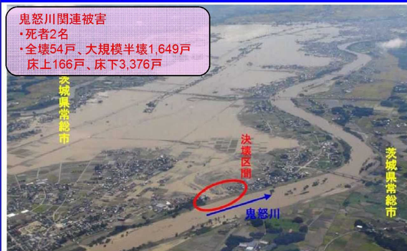
決壊区間航空写真(H27/9/11撮影)
