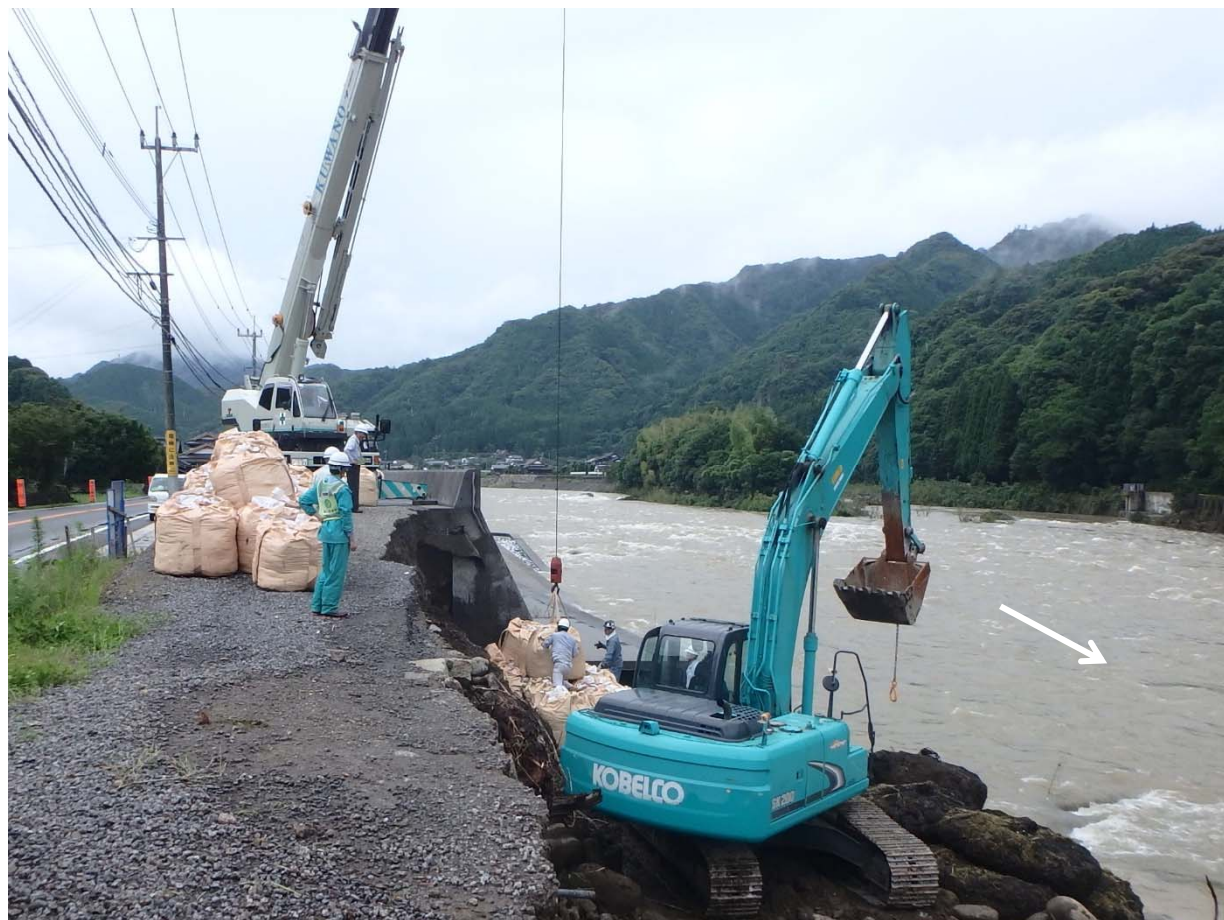
応急復旧作業状況（山国川右岸19k200付近） 【中津市本耶馬溪町多志田地区】
