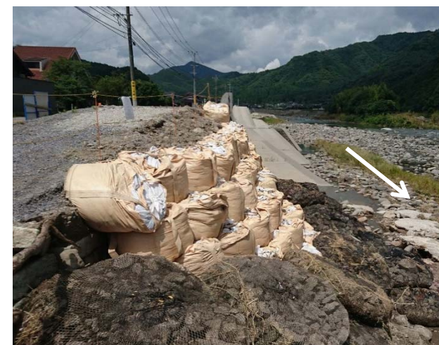
応急復旧完了
