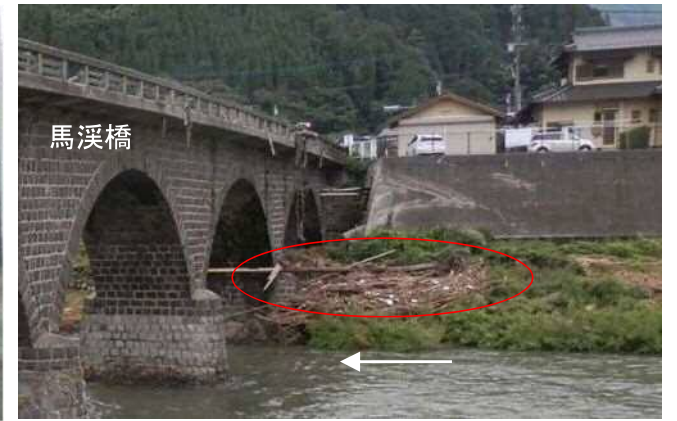
馬溪橋流木閉塞状況
