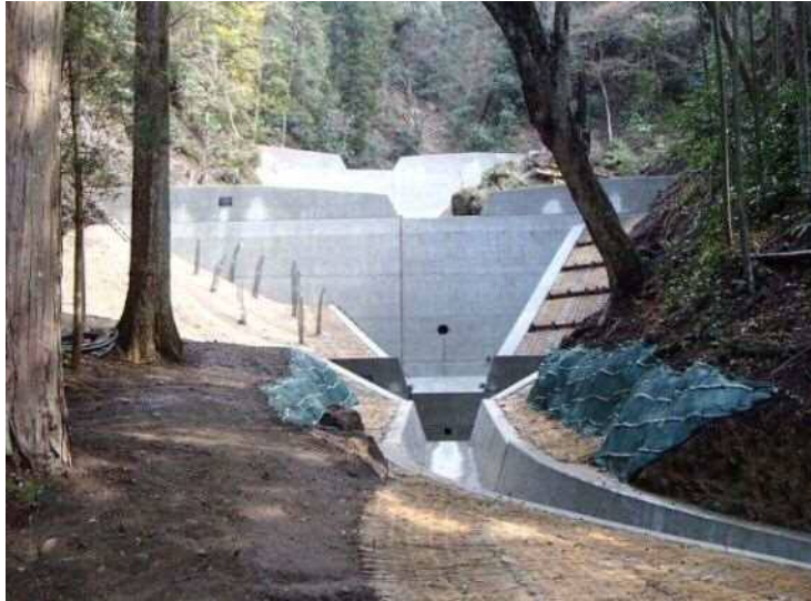
中津市山国町中摩字玉取（H 2 5 年施工）
