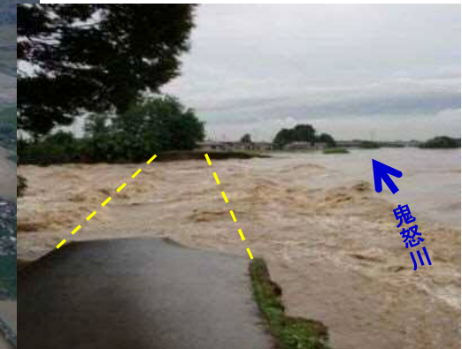
被災状況(拡大写真)
