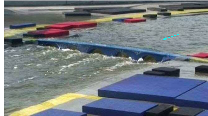
② 馬溪橋による堰上げ状況(下流左岸より)
