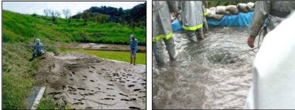
洪水時の堤防等の漏水
