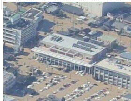
常総市役所の浸水の状況
