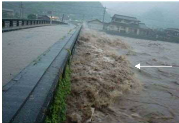
馬溪橋左岸側より上流を望む
