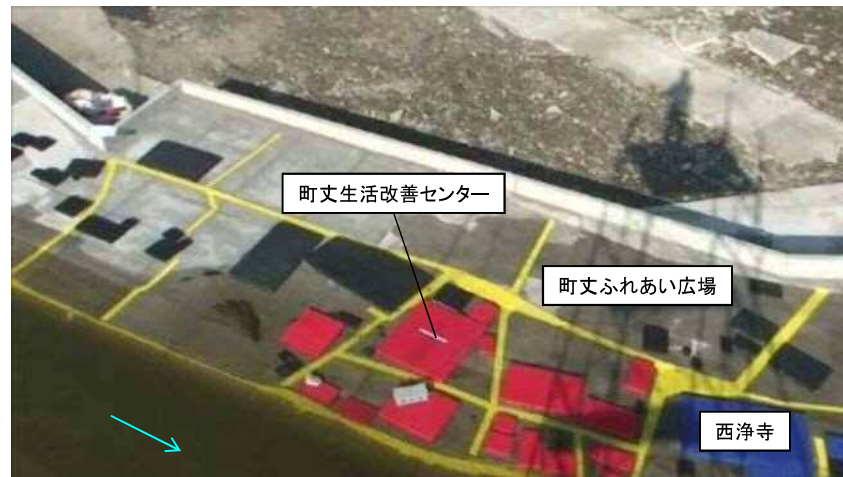
④ 馬溪橋左岸堤内地浸水状況
