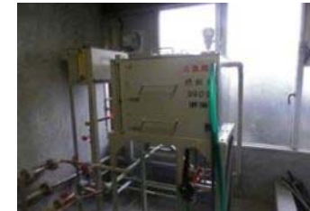
発電室の一例
