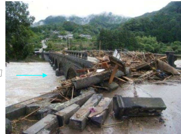
耶馬溪橋の被災状況(H24.7.3洪水時)
