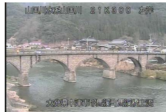
山国川CCTVカメラ画像設置(馬溪橋)
