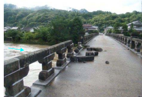
羅漢寺橋の被災状況(H24.7.3洪水時)
