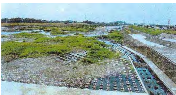
写真 2.2.1 平成大堰下流の渇水状況 (平成 13 年)
