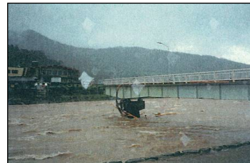
曾木地区 橋の流失
