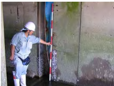
写真 2.1.2 樋門・樋管等の点検状況
