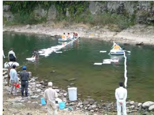
写真 4.3.9 オイルフェンス、吸着マットの設置状況（水質事故訓練にて）
