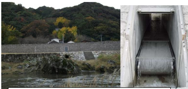
樋管における無動力開閉ゲートの採用
