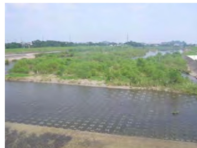
写真 2.1.3 土砂堆積及び樹木繁茂状況
