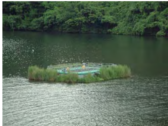
写真 2.2.4 耶馬溪ダム水質保全装置 (深層曝気設備)
