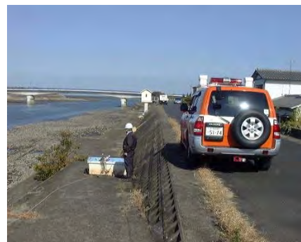
写真 4.3.1 河川巡視状況
