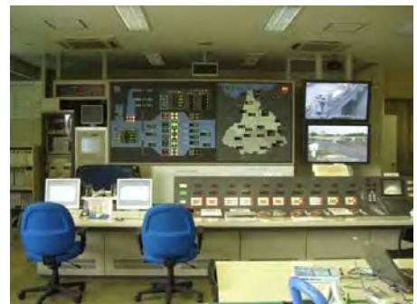
写真 4.3.3 山国川河川事務所内操作室
