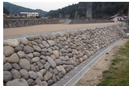
石積における現地発生材の利用
