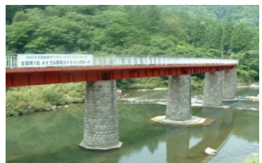
サイクリングロード（旧耶馬溪鉄道跡）
