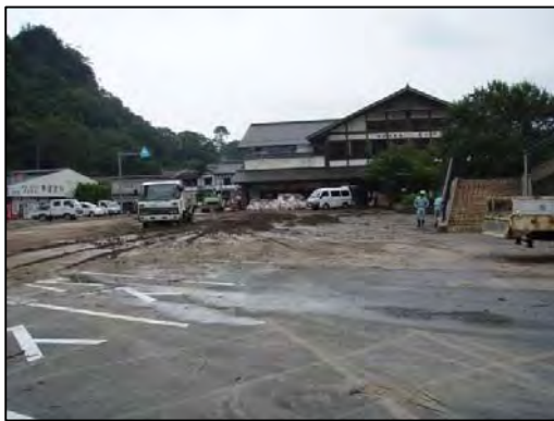
写真 1. 2. 4 曾木地区出水後の状況 (平成 19 年 8 月)
