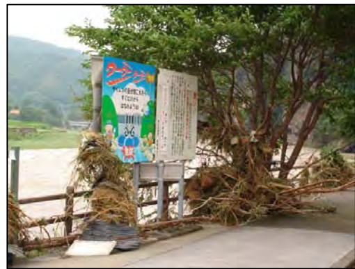
写真 1. 2. 5 曾木地区出水後の状況 (平成 19 年 8 月)
