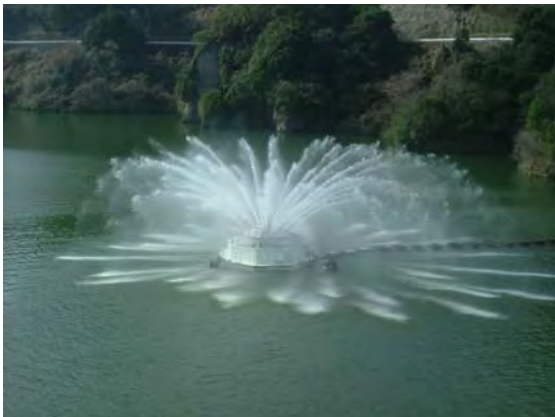
写真 2.2.3 耶馬溪ダム水質保全装置 (貯水池循環設備)
