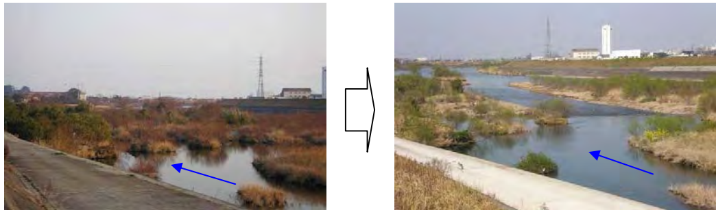
土砂堆積及び樹木繁茂
