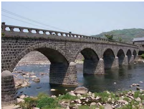
写真 2.3.7 耶馬溪橋（オランダ橋）
