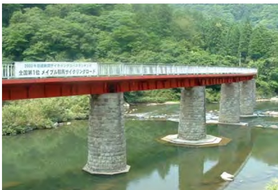
サイクリングロード（旧耶馬溪鉄道跡）
