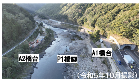
松本橋の工事状況
