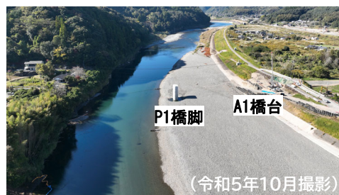
沖鶴橋の工事状況
