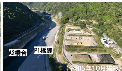
大瀬橋の工事状況
