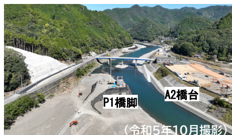
坂本橋の工事状況
