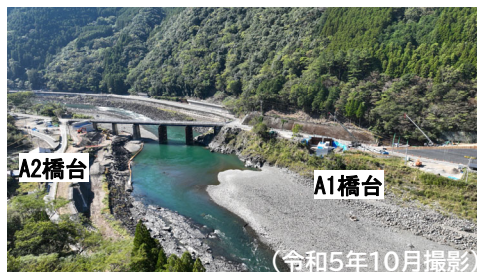
鎌瀬橋の工事状況
