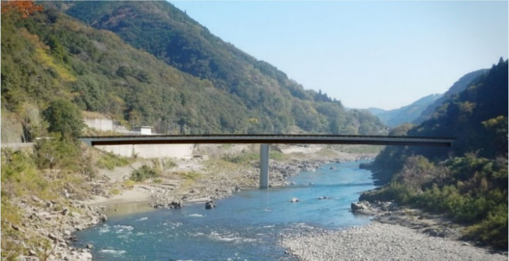
鋼2径間連続鋼床版箱桁橋
