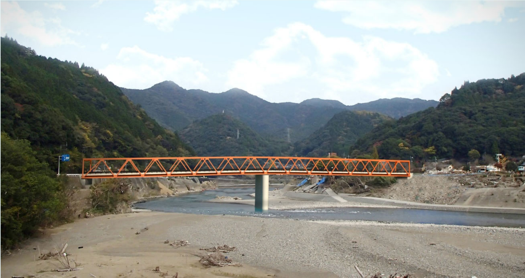
鋼2径間連続トラス橋
