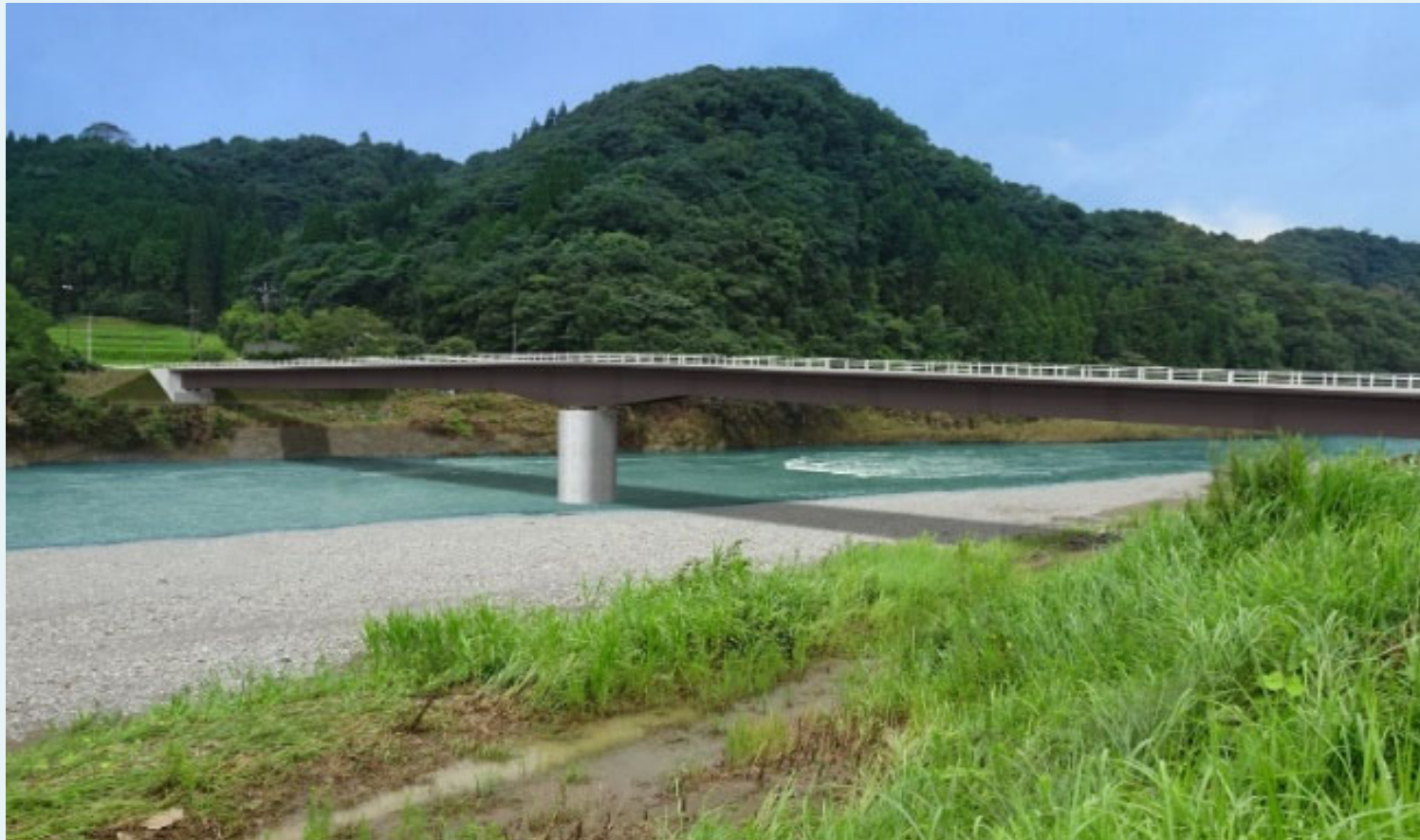
鋼2径間連続鋼床版箱桁橋
