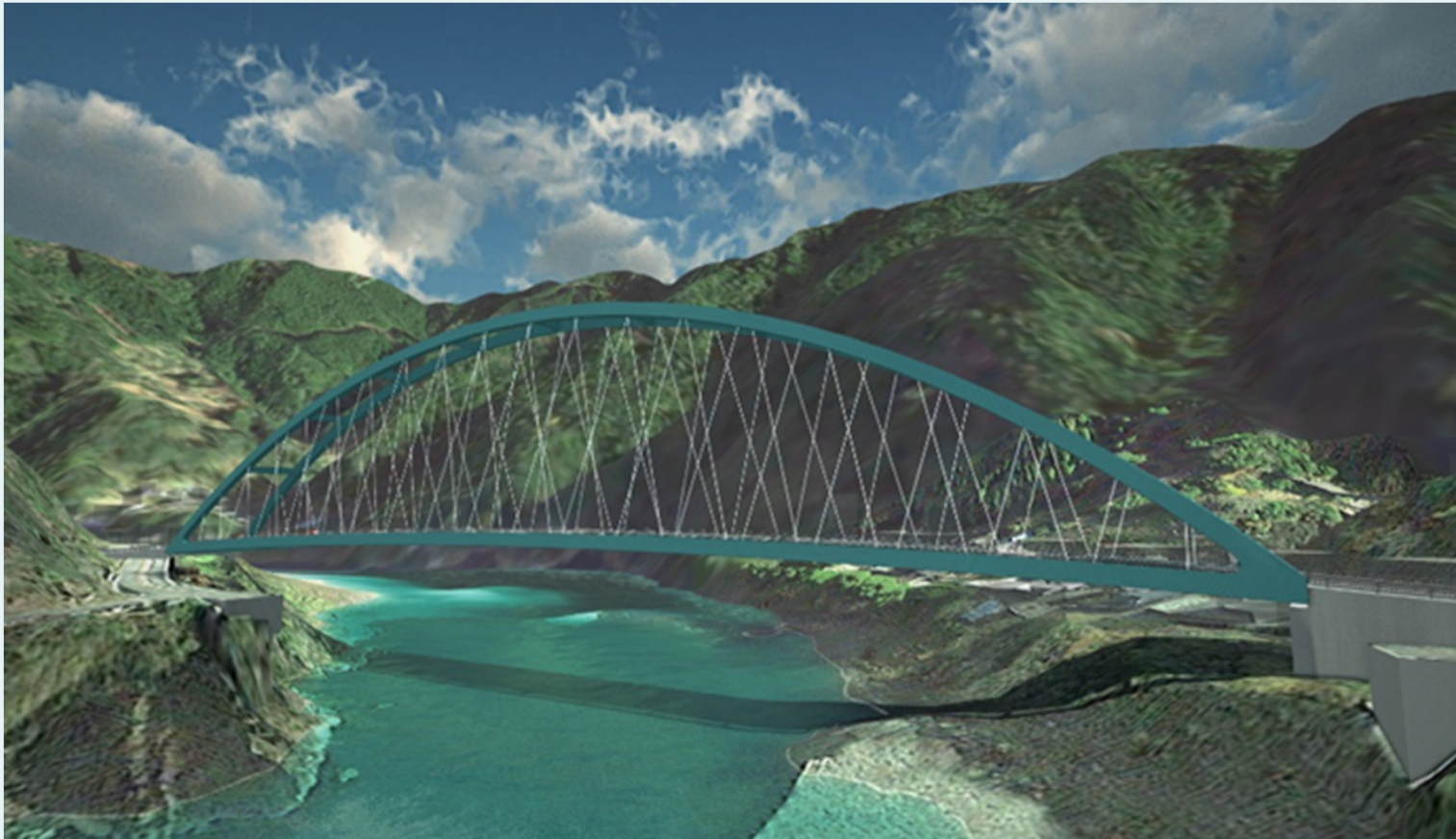
鋼単純アーチ橋(ニールセンローゼ桁)
