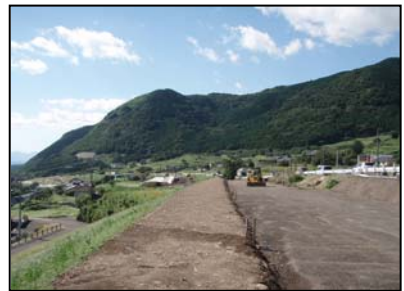
▲立野地区改良工事状況
