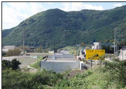
▲ 本村橋下部工状況写真
