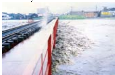
H27.2出水状況（JR白川第一橋梁）
