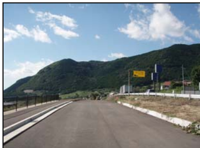
▲立野地区改良工事状況
