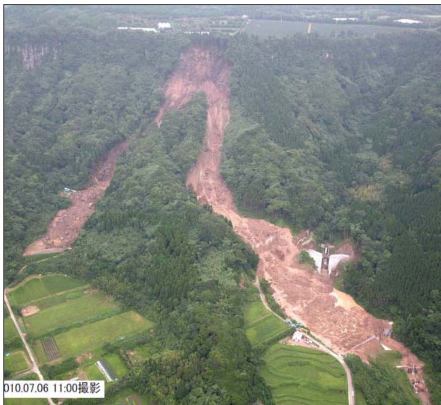
鹿児島県南大隅町根占山本 船石川
