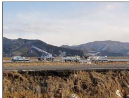
緊急復旧工事状況
