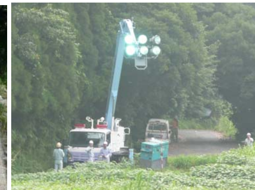
夜間監視用の照明車の設置状況
