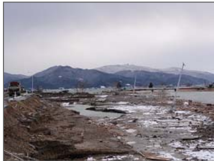
堤防被災状況
