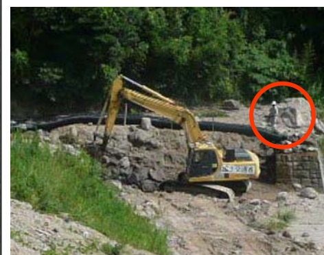
ロボQ(簡易遠隔操縦装置)の作業状況
