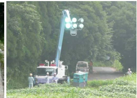
夜間監視用の照明車の設置状況
