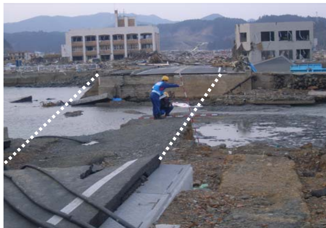
しづかわ 南三陸町志津川 現地調査 (国道45号:川尻橋)
