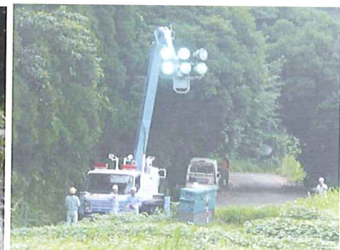
夜間監視用の照明車の設置状況
