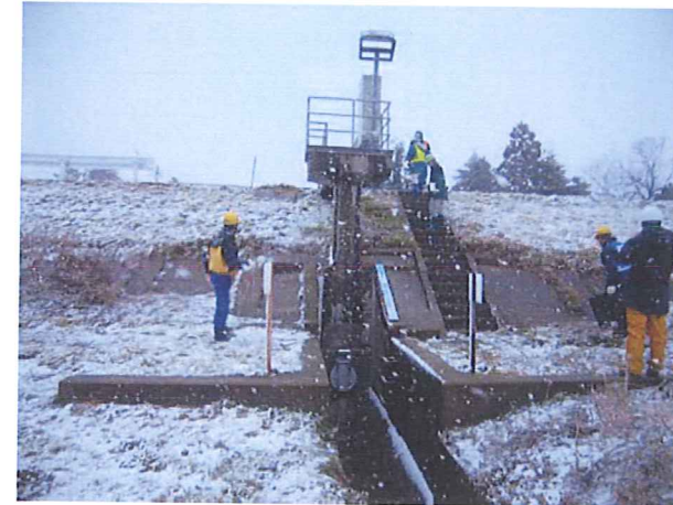
河川構造物(排水樋管)の被災調査状況
