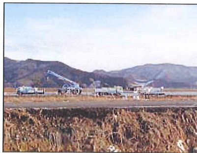
緊急復旧工事状況
