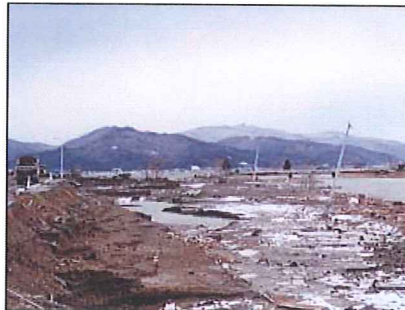
堤防被災状況
