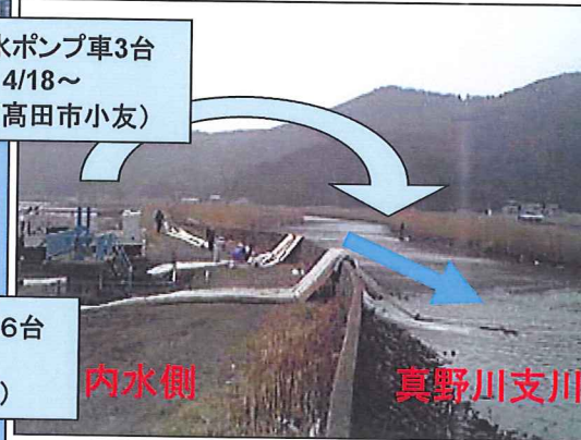
石巻市真野川支川への排水状況
