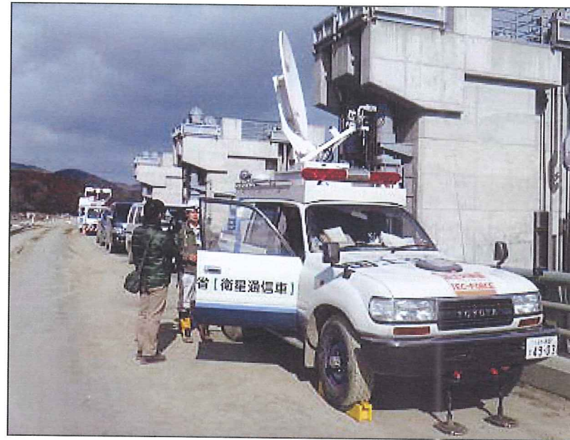
衛星通信車設営状況
