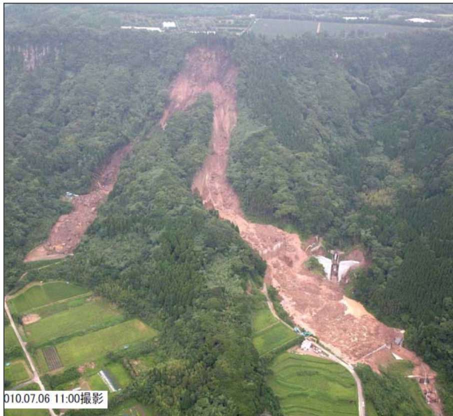
鹿児島県南大隅町根占山本 船石川
