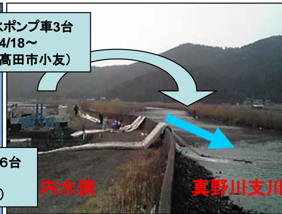
石巻市真野川支川への排水状況
