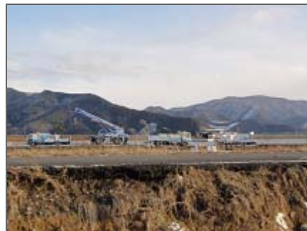
緊急復旧工事状況
