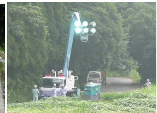
夜間監視用の照明車の設置状況
