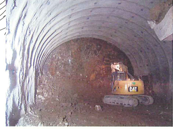
現在の工事状況です。
