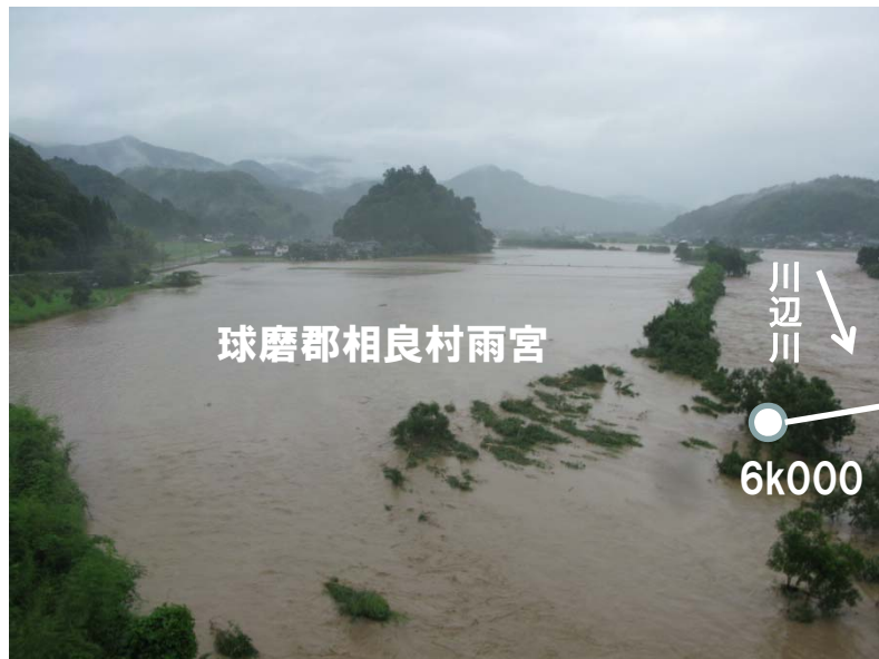
相良大橋より上流を望む【川辺川】 (12日13時30分頃)
