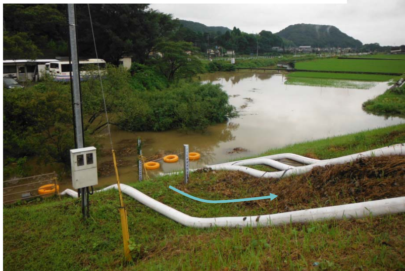
今村第2樋管 川裏 ポンプ投入状況
