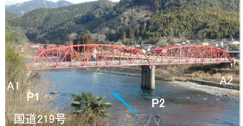
被災前の状況(平成15年 3月時点)
