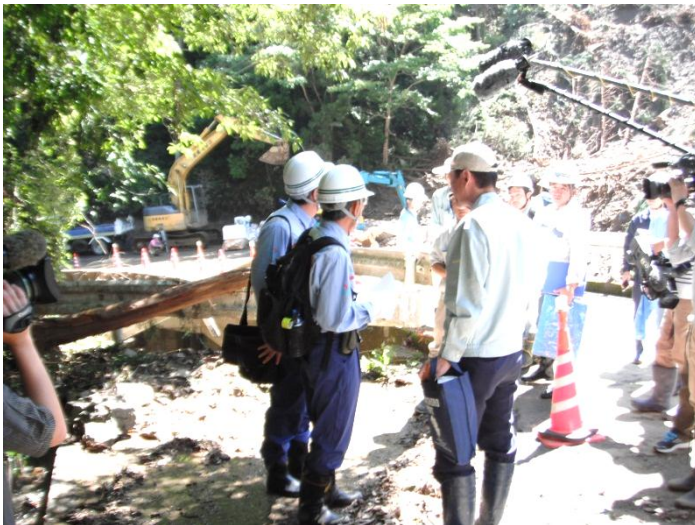
▲現地調査状況(市道市ノ俣線)
