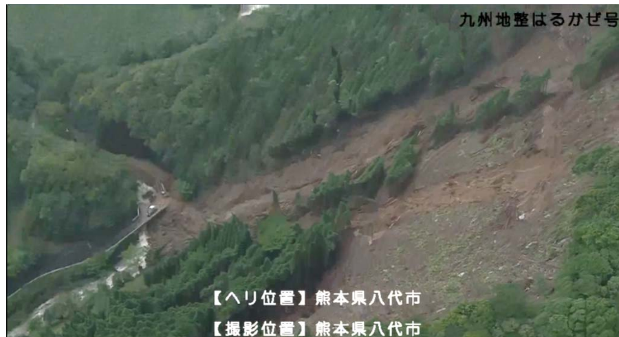
▲崩壊状況(国土交通省より防災ヘリコプター「はるかぜ号」を派遣し撮影)
