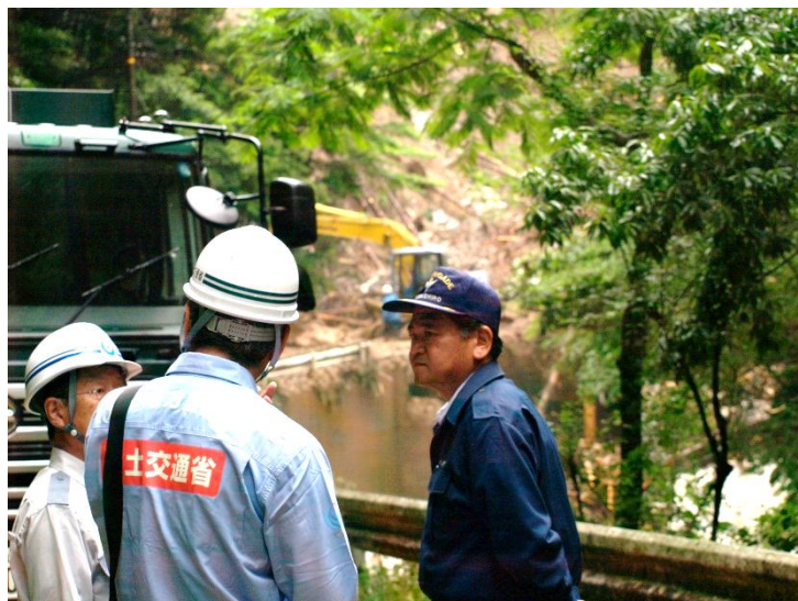
▲中村八代市長へテック隊員である八代河川国道事務所副所長が対策工法への助言
