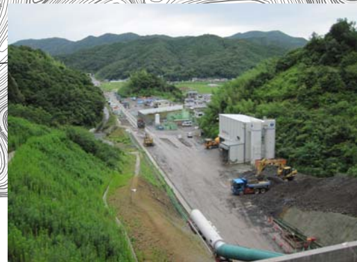
八代側坑口ヤード（写真①）
