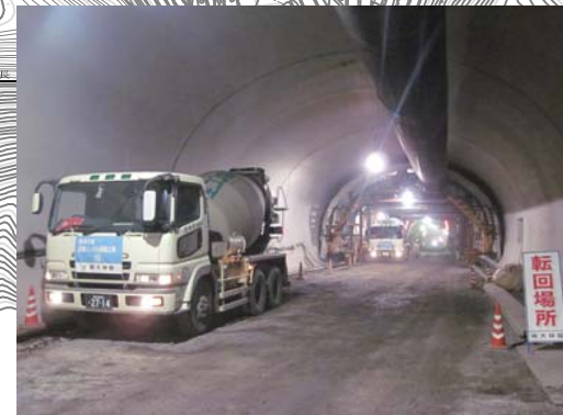
トンネル覆工状況（写真②）
