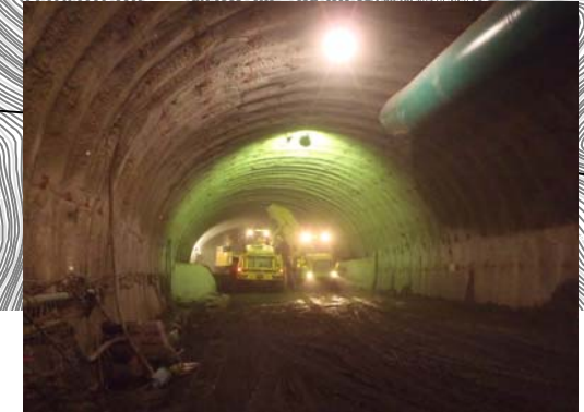
トンネル掘削状況（写真③）
