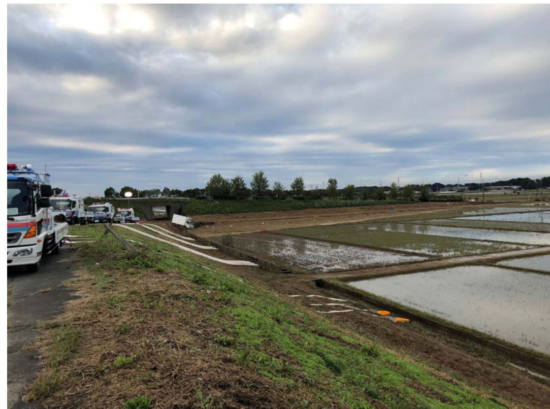
排水作業（15日6時頃）
