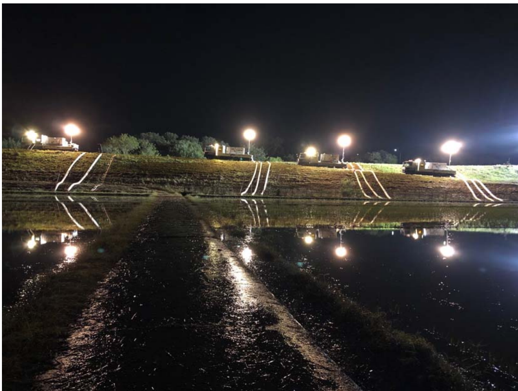
排水作業（14日23時頃）
