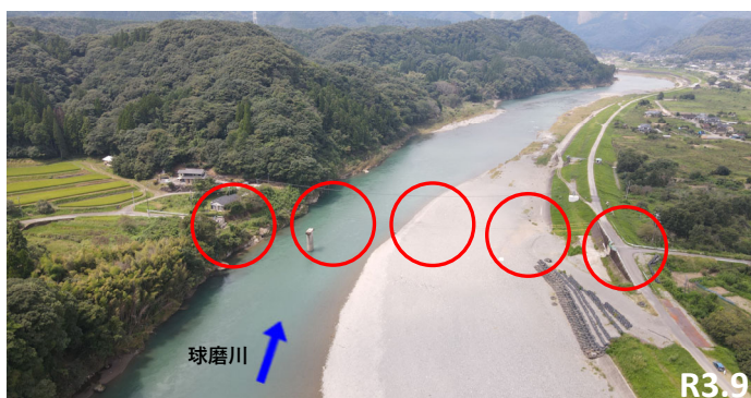
【復旧位置写真（沖鶴橋）】
