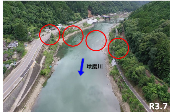
【復旧位置写真（神瀬橋）】
