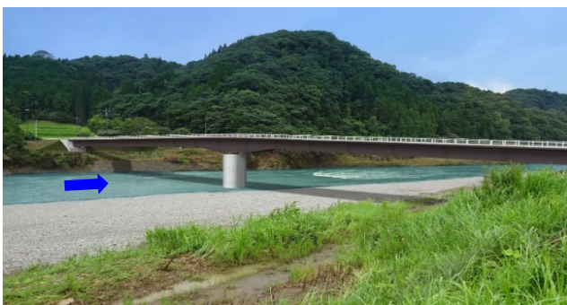
沖鶴橋【鋼2径間連続鋼床版箱桁橋】
