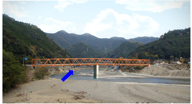
坂本橋【鋼2径間連続トラス橋】
