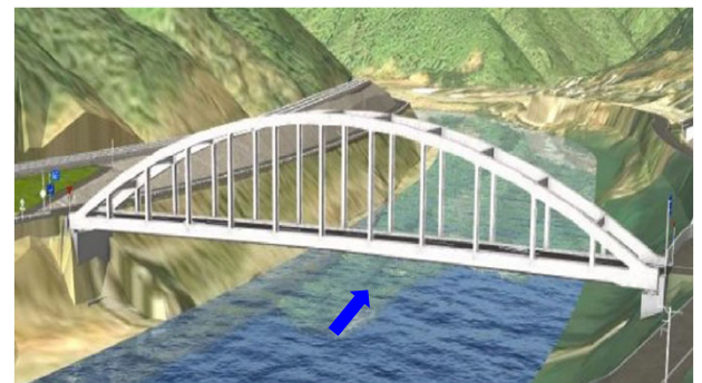
神瀬橋【鋼単純アーチ橋】
