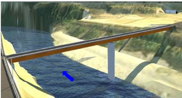
大瀬橋【鋼2径間連続鋼床版箱桁橋】
