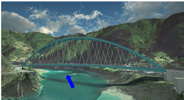
鎌瀬橋【鋼単純アーチ橋】
