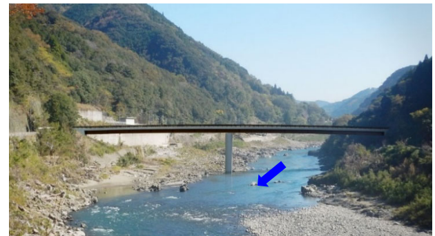
松本橋【鋼2径間連続鋼床版箱桁橋】
