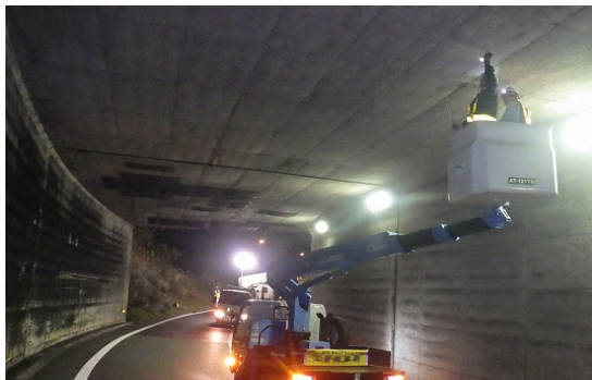
< ボックスカルバート点検 >
