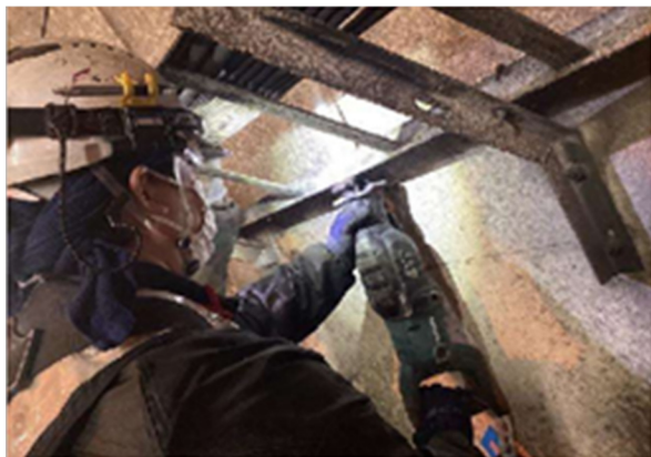
<ケーブルラック更新工事>
