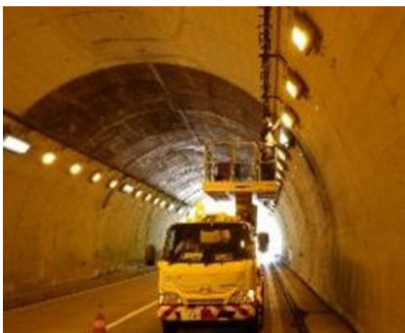
<トンネル照明点検>
