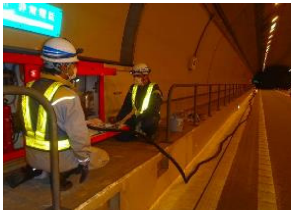
<トンネル非常用設備点検>
