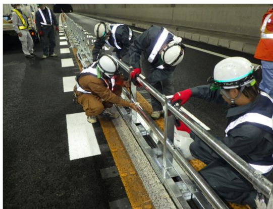
< 区画柵設置工事 >
