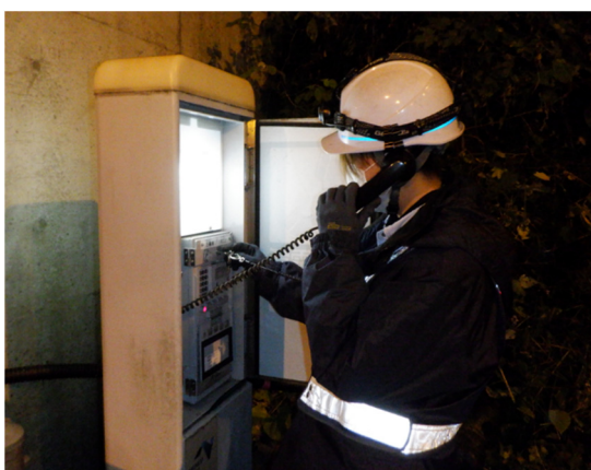
< 非常電話設備点検 >
