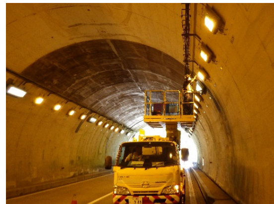
< トンネル照明点検・取替 >
