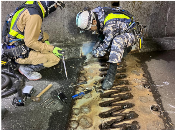
＜伸縮装置フェースプレート高力ボルト取替＞
