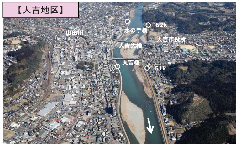
人吉市街部を貫流し、沿川には家屋、ホテル等が立地している
