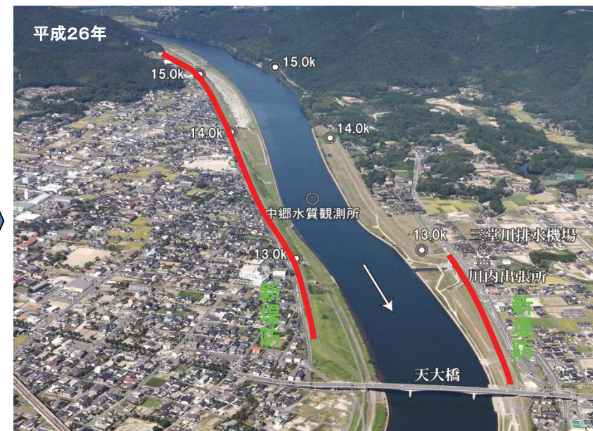
川内川水系川内川【鹿児島県】
