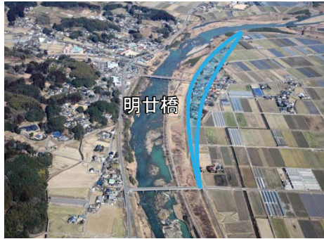
川瀬橋付近の写真
