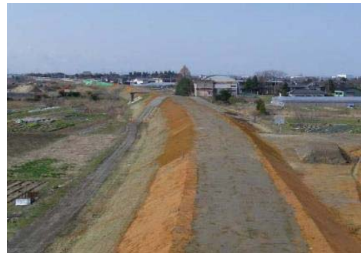
※高さが不足していた堤防を嵩上げたもの
