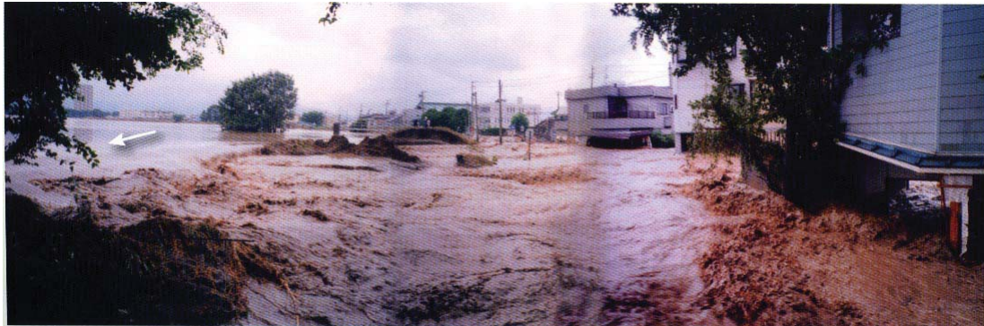
越水により堤防が決壊した事例
